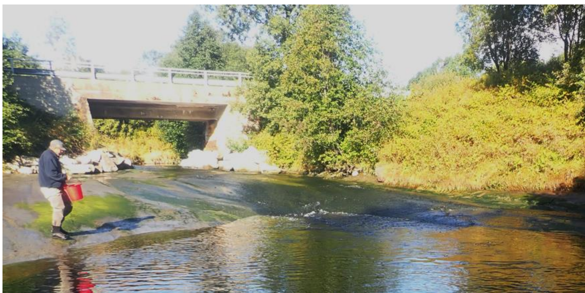
Figur 30. Frie vandringsveier knyttet til nedre del av Daloselva ved Buvikveien, der elva går over et parti fast fjell og berg før flo-sone. Foto: NINA.
