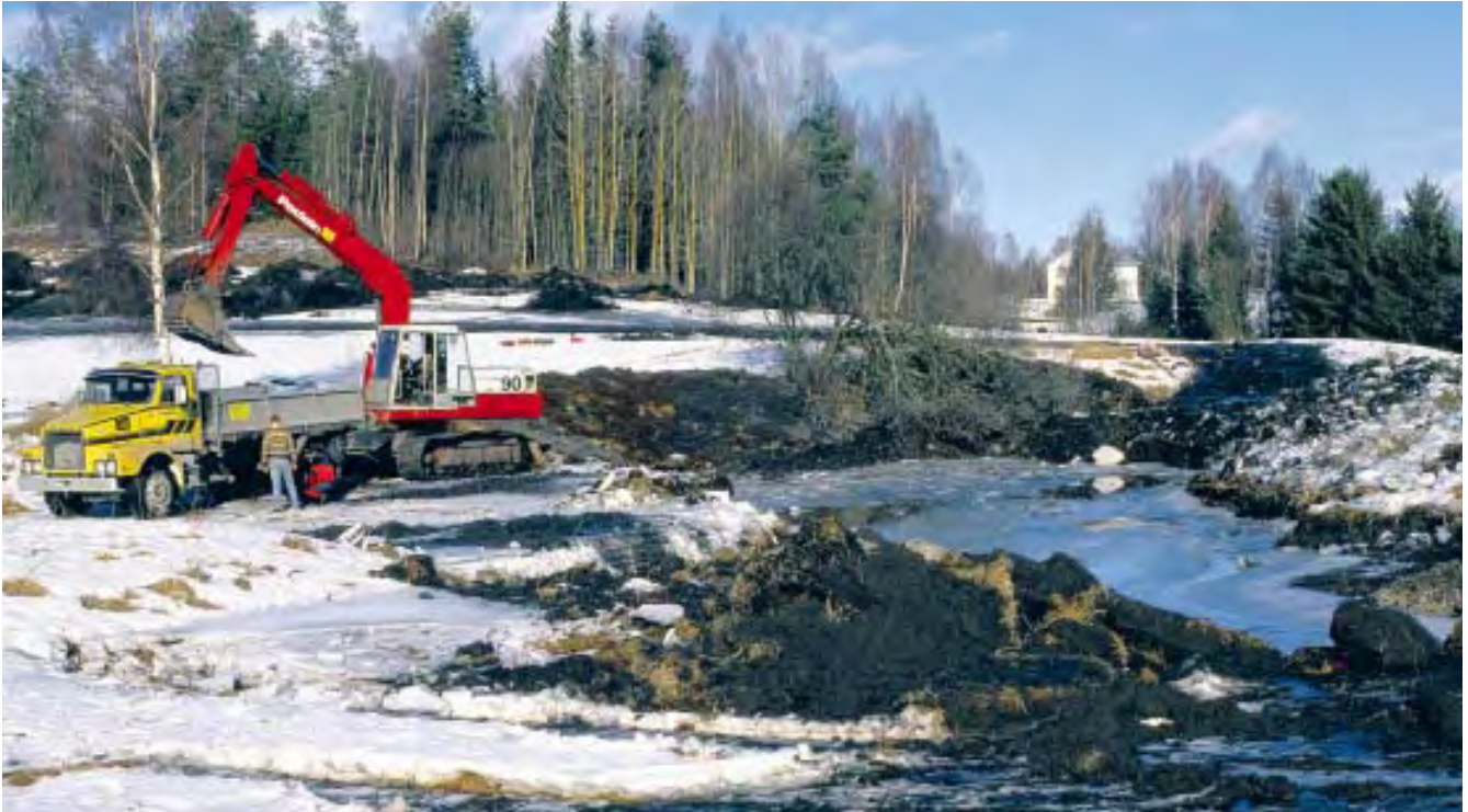
Det kan være mange fordeler ved å grave ut dammen om vinteren. Bakken bærer bedre, og det er lett å transportere vekk masse. Ved vintergraving vil vollen rundt dammen kunne inneholde frossen jord (teleklumper). For større damanlegg bør en derfor vente med å fylle dammen til massen har sunket sammen og satt seg. Det kan være praktisk å pakke massene ved å kjøre fram og tilbake med en beltegraver. Foto: Hallvard Strøm
