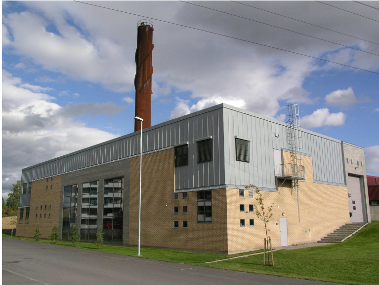
Børstad varmesentral 5,5 MW bio. Hamar Hamar-reg.Fj.varme AS (2003)
