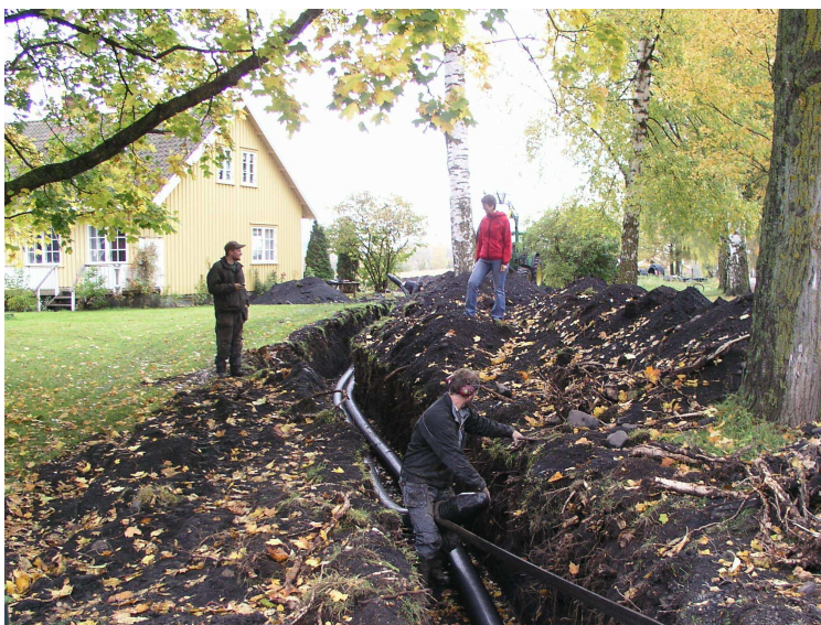
Legging av fjernvarmerør på Grimerud i Stange (2007)
