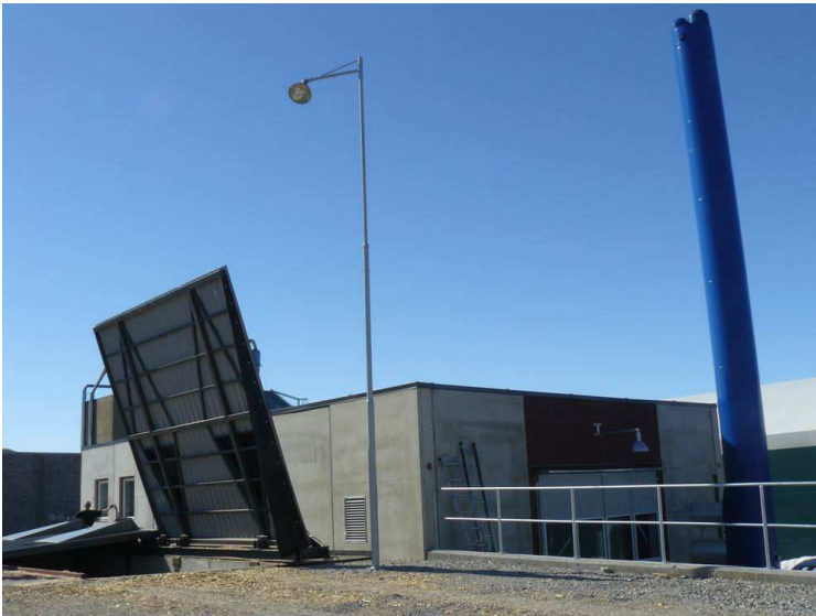
Varmesentral på Tynset 2 MW bio. Holmen Biovarme AS (2006/2007)
