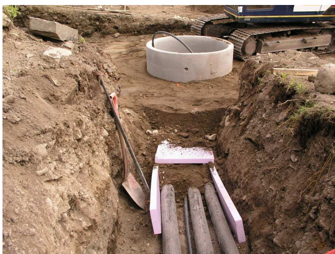
Legging av gardsvarme nærvarmerør på Fjetre i Stange(2004)
