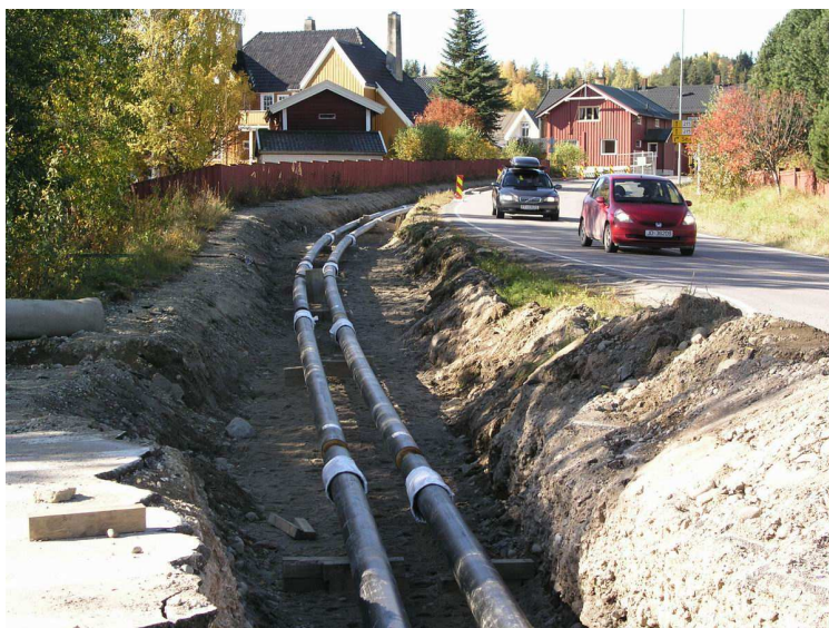
Fra legging av fjernvarme på Rena( 2007)
