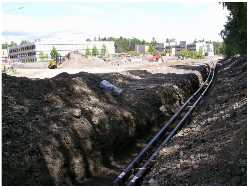
Fra legging av fjernvarme ved skoleanleggene på Hamar Vest (2006)
