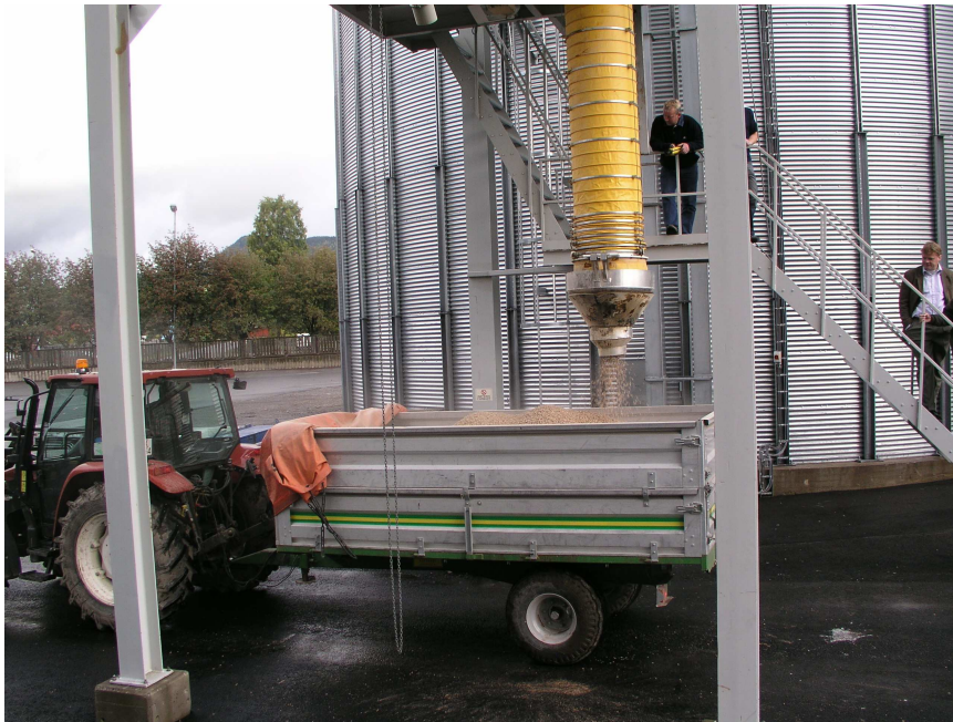
Fylling av pellets på traktorhenger ved pelletsanlegget i Brumunddal
