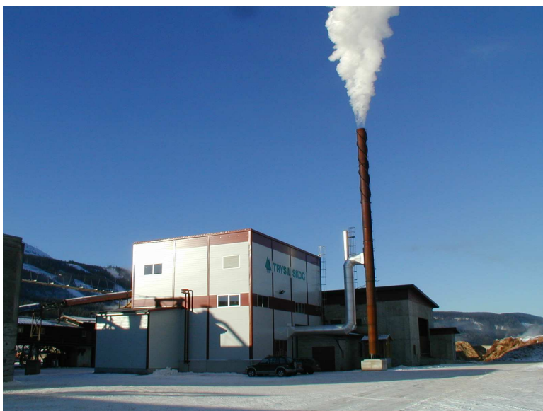
Varmesentralen ved Trysil fjernvarme 7,5 MW bio( 1980/2003)
