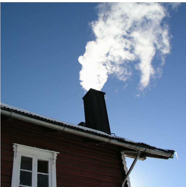
Riktig forbrenning gir bare synlig vanndamp og godt utbrent og grå aske!
