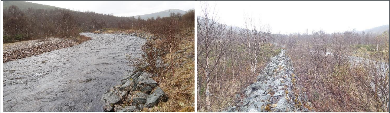
Figur 11. Tv. Sees sikringsanlegg i elvesving ferdigstilt i 2003, th. gammelt udatert sikringsanlegg, som hindrer vann i å trenge inn i sideløpet mot fylkesveien.
