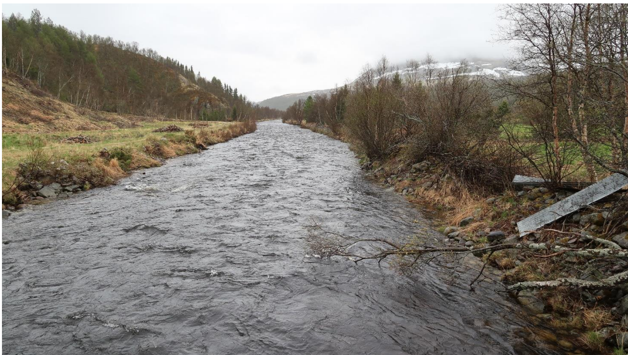
Figur 22. Hola sett nedstrøms fra brua ved Nordigarden 1. juni 2022. Elvemasser er gravd ut, og anbrakt på elvesidene.
