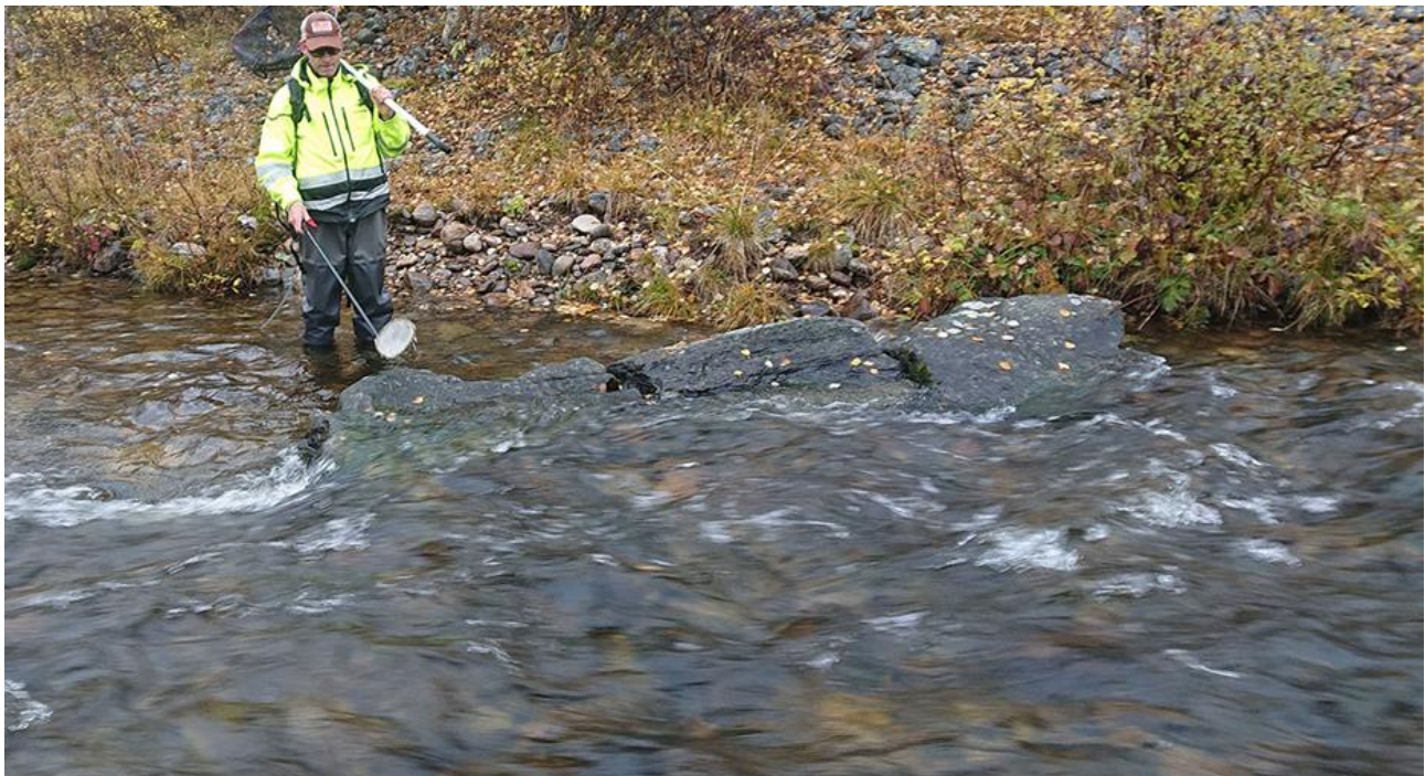
Figur 10 Erosjonssikring i elvesiden, sammen med en anlagt bune (Biotoptiltak, etablert 2003.09.24).
