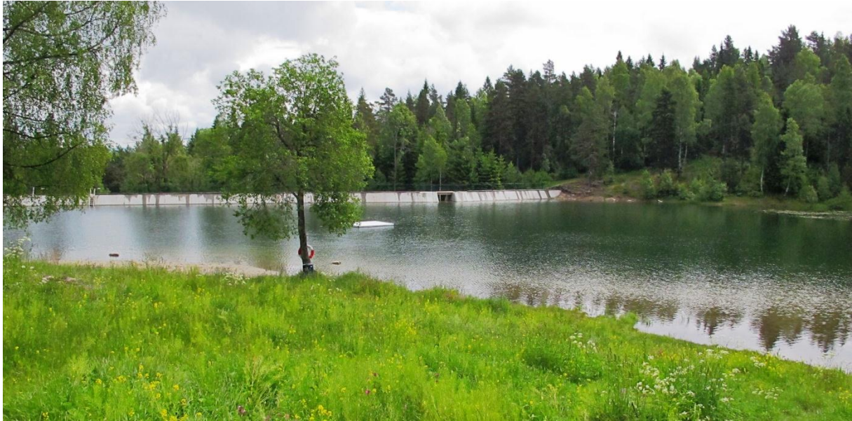
Figur 32. Blekkjern, nordre del ved demningen. Foto 17.6.2012
