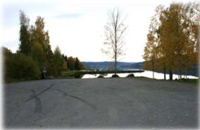
P-plassen mangler HC p-plass
