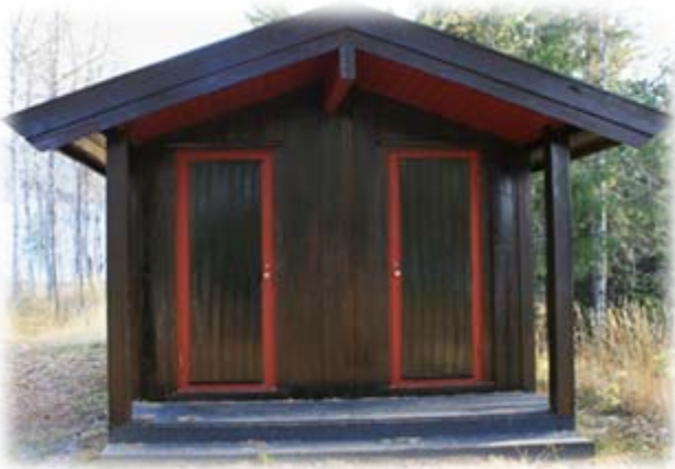
Toalett: Ikke adkomst med rullestol
