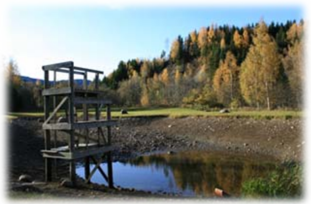
Lav vannstand..Stuping anbefales ikke!
