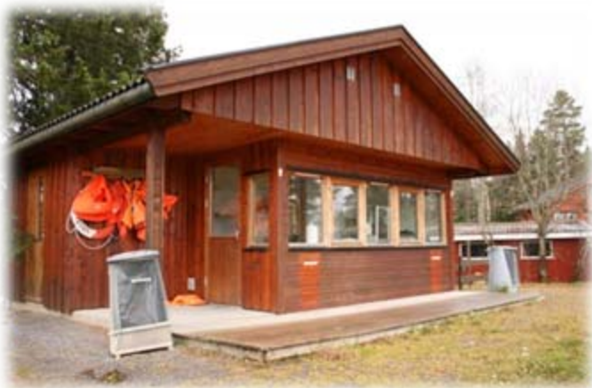
Kiosk, men den høye rampa er et hinder....
