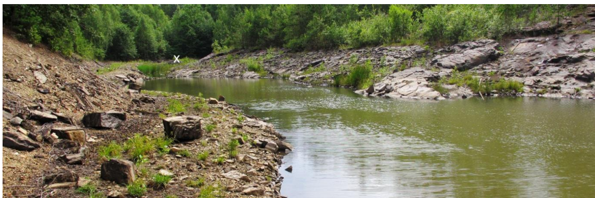
Figur 29a. Skaugdammen sett mot sør. Foto 23.7.2012
