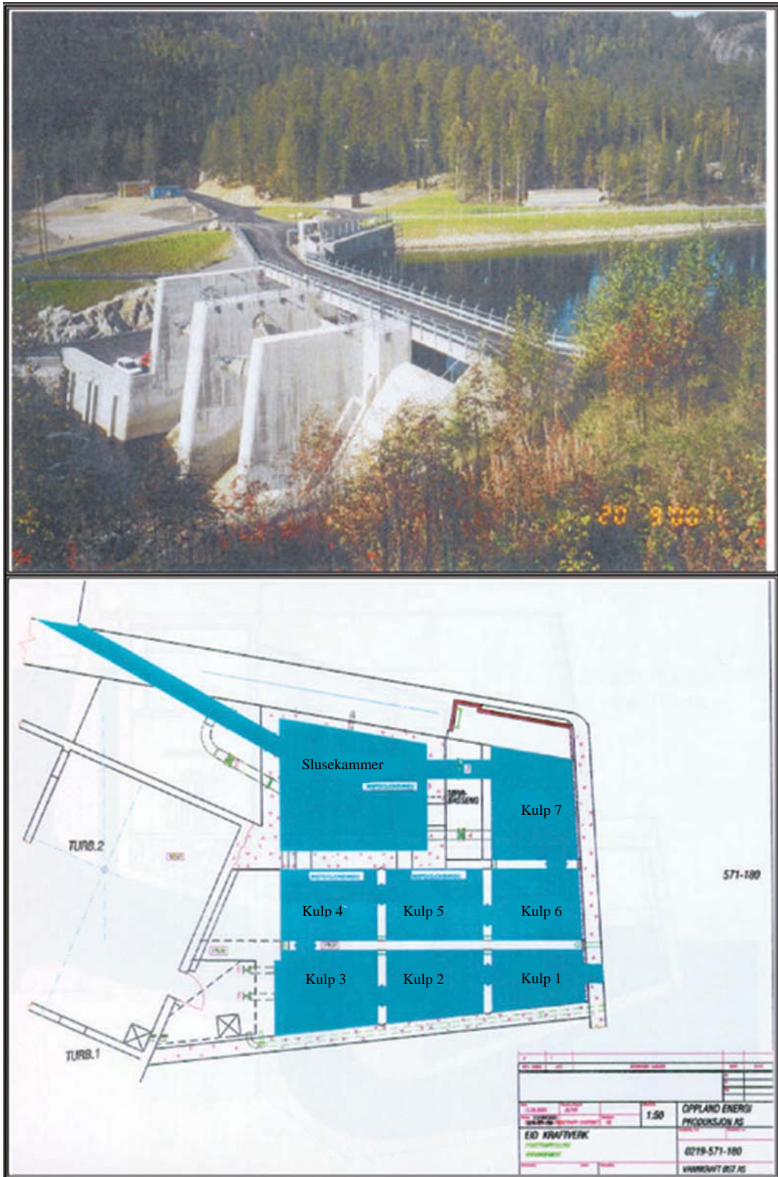
Figur 2. Eid kraftverk (foto hentet fra Vannkraft Øst rapport) (øverst). Tverrsnitt av fisketrappa sett ovenfra (nederst).
