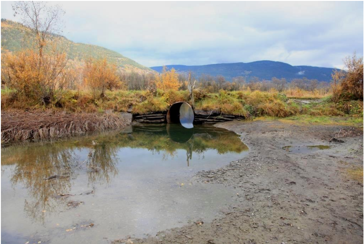
Figur 36. Kulvert under landbruksvegen ved Gautøya som skal sikre noe kontakt mellom hovedelva og flommarkene innenfor. Dette er imidlertid en løsning som medfører minsket kontakt sammenlignet med en naturlig situasjon. Foto: Geir Høitomt, 10.10. 2014
