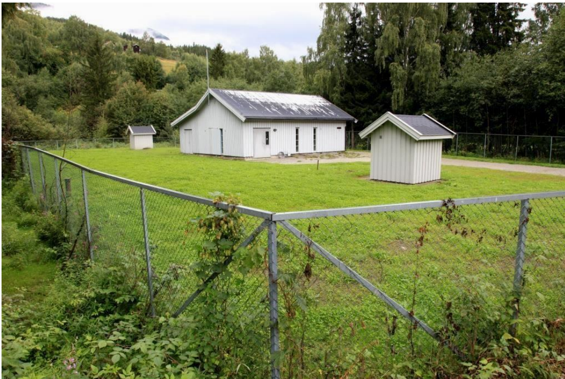
Figur 27. Kommunalt vannverk (Brauta vannverk) ved Moeselva på vestsida i reservatet (gnr/bnr 98/34). Foto: Geir Høitomt, 24.8.2014.
