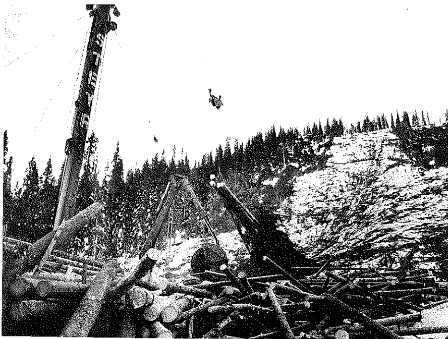
Tung kabelkran av østerriksk fabrikk i drift i Trysil.
