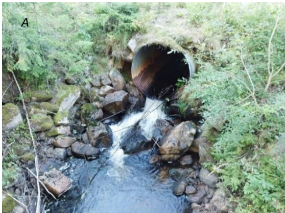
Figur 27: A: Dronebile av Austgardsåa med kulvert ansett som vandringshinder. B: Dronebilde av Austgardsåa nedstrøm Håkerudvegen og kulvert.
