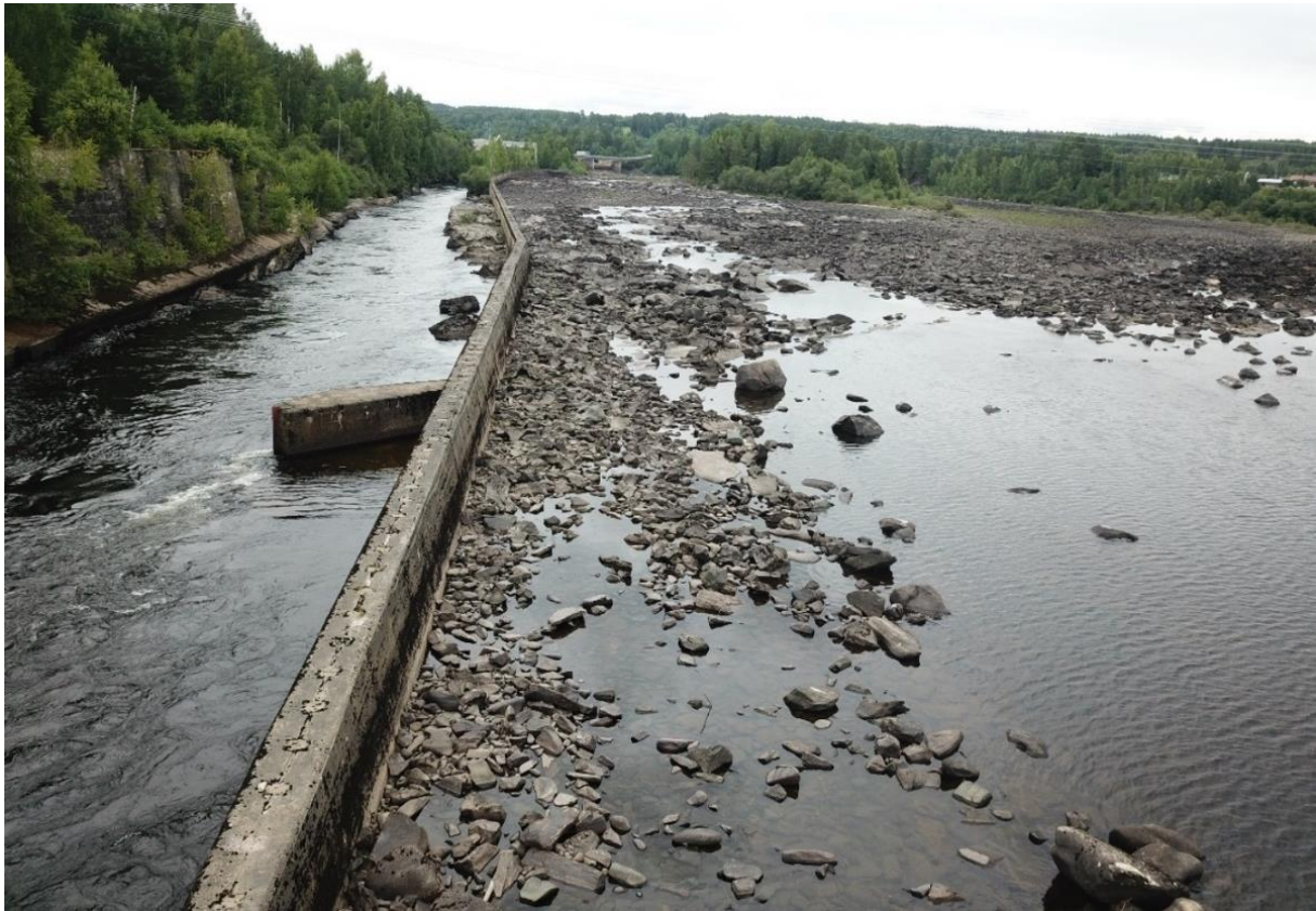
Figur 65: Dronebilde tatt omtrent 500 m nedstrøms dammen. I venstre del av bilde ser man avløpskanalen som fører vannet som kommer fra kraftverket. Høyre del av bildet viser minstevannstrekningen.
