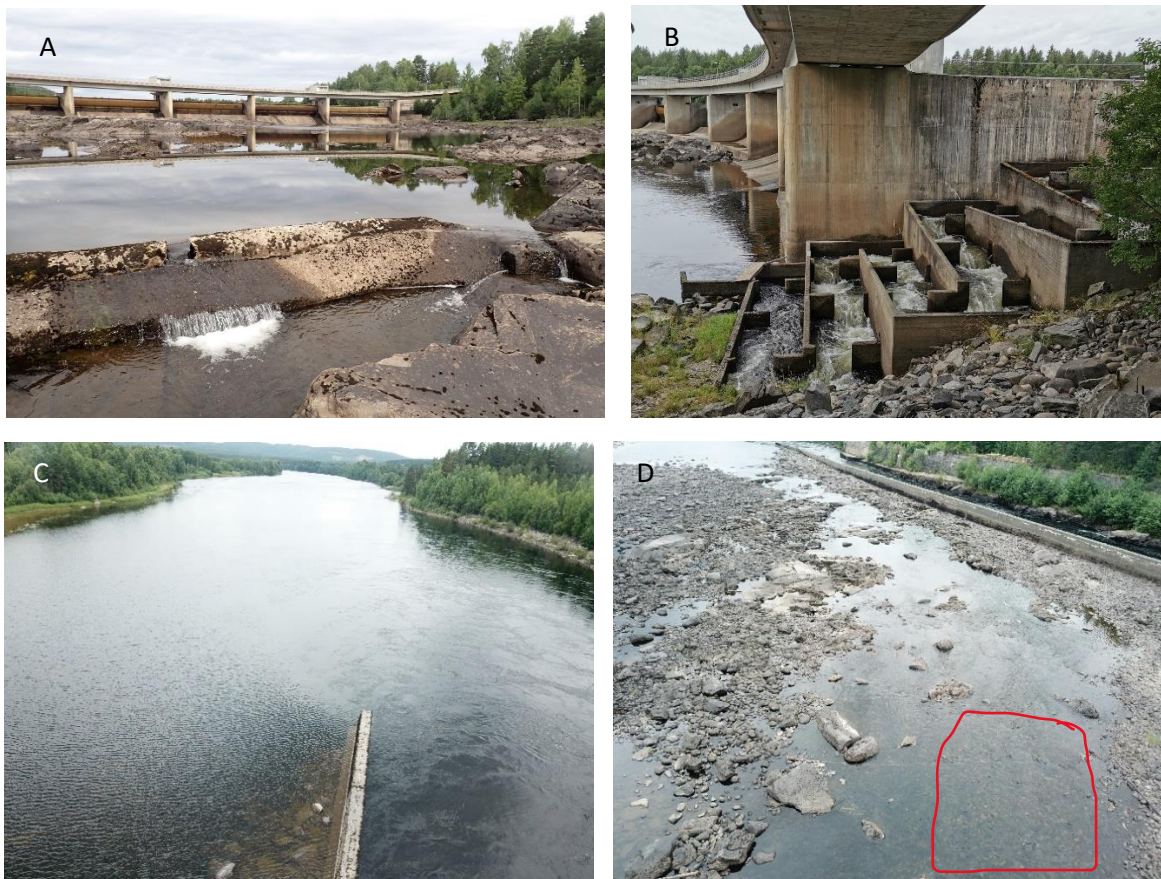
Figur 67: A: Bilde av dammen i minstevannstrekningen hvor det lekker vann. B: Bilde av fisketrappa på østsiden, like under damkronen. C: Dronebilde tatt 500 m nedenfor dammen. D: Dronebilde av nedre deler i minstevannstrekningen, med gytehabitat tegnet i rødt.
