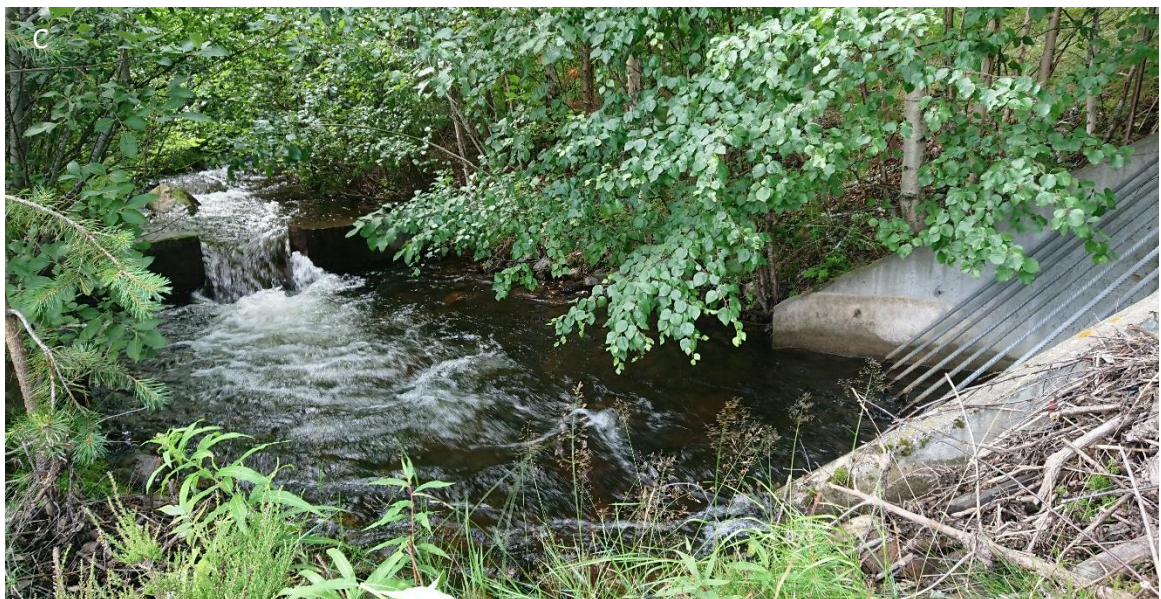
Figur 72: A: Deniltrapp, som er starten av fiskepassasjen på vestsiden ved kraftverksutløpet. B: Oppvandrende fisk går videre inn i en tunnel. C: Resterende fiskepassasje består av naturlikt elveløp med rikelig kantvegetasjon.
