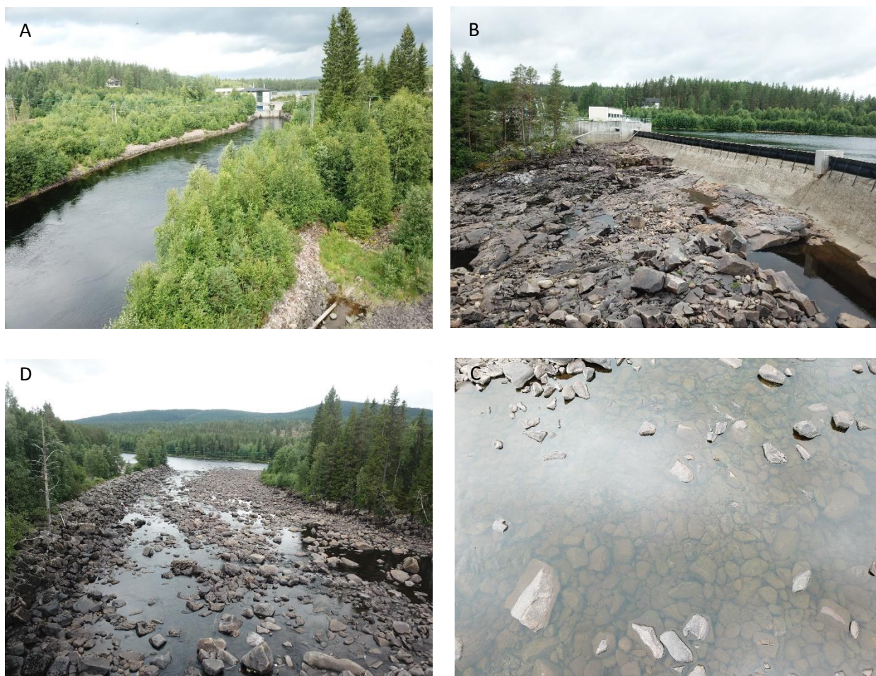
Figur 70: A: Utløpet fra kraftverket. B: Dammen, kraftverket og minstevannstrekningen. C: Minstevannstrekningen sett nedstrøms. D: Bunnssubstrat i minstevannstrekningen, i hovedsak bestående av større stein (> 30 cm).
