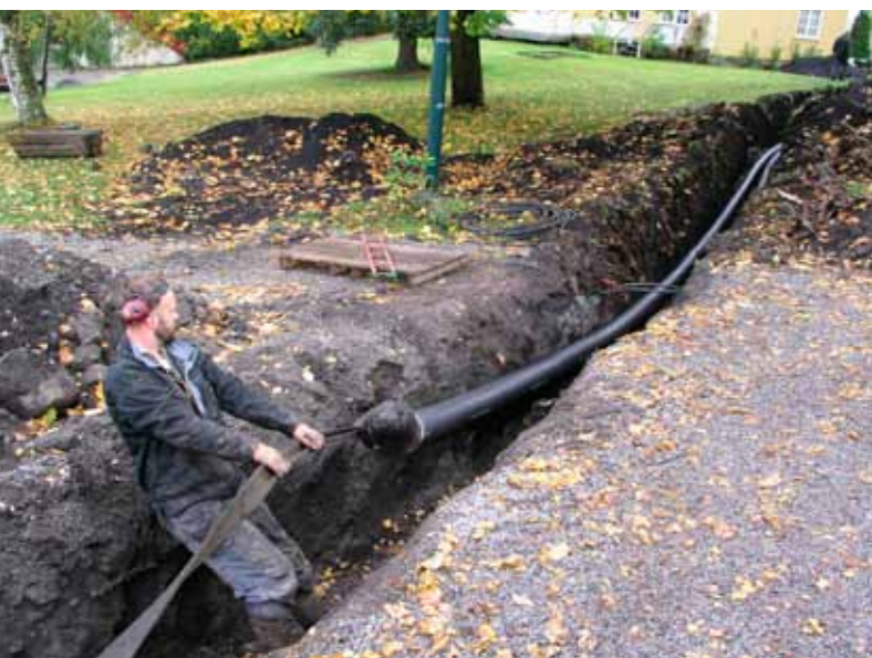
Nærvvarmerør. Foto: Eiliv Sandberg.
